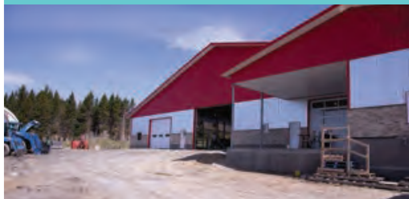
La nouvelle étable construite à l'été 2022.
